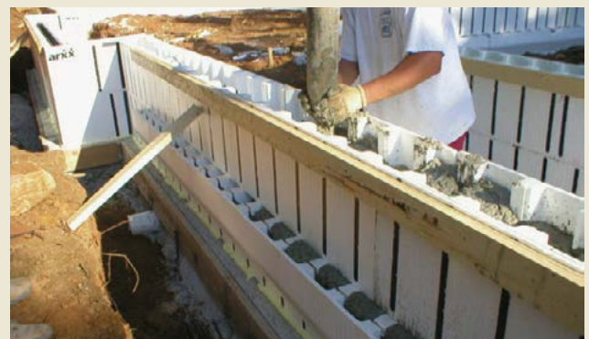
Figure 2 Coulage d'un mur en CBI
